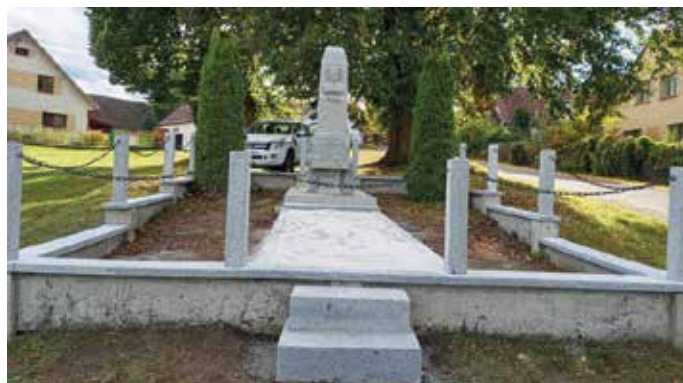
Oprava pomníku padlým v Malonicích.
