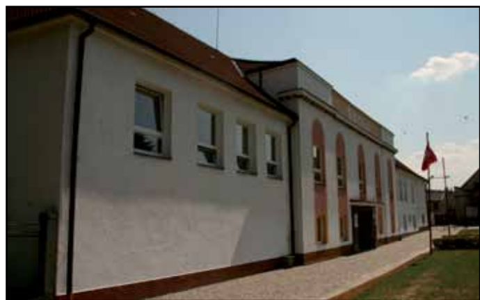
Nový chodník před budovou základní školy.
